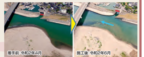
手取川河口付近堆積土砂大規模浚渫工事 この工事により、美川漁港への船の出入りがスムーズになりました。
